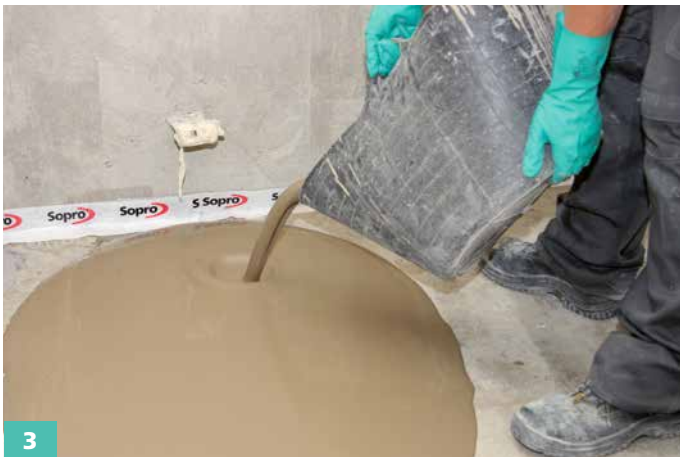
3 Die angemischte Fließspachtelmasse auf dem grundierten Untergrund (siehe Kapitel 1) ausgießen.
