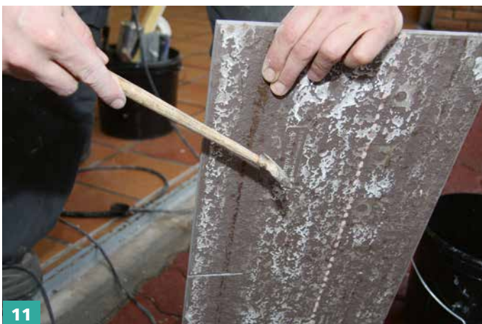
11 Zum Brechen stärkerer Platten vorsichtig mit dem Fliesenhammer von der Plattenrückseite entlang des Ritzes klopfen.
