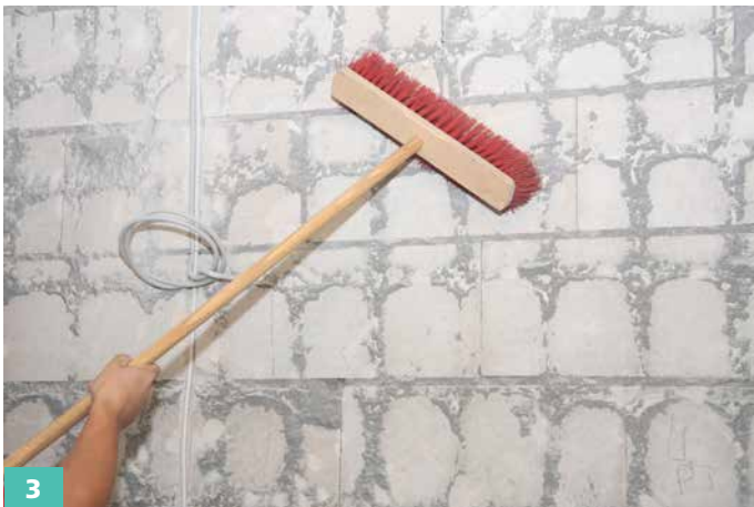
3 Lose Teile und Staubreste mit einem Besen entfernen.
