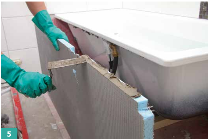
5 ... sowie auf die Platte selbst auftragen.
