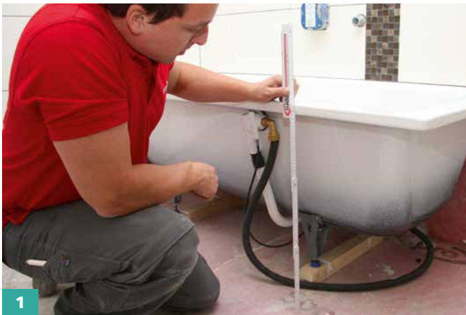
Den zu verkleidenden Bereich genau ausmessen ...
