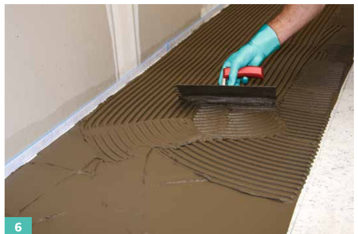
6 Die anschließende Fliesenverlegung erfolgt direkt auf der Sopro FliesenDämmplatte. In Feuchträumen ist Sopro FliesenDämmplatte durch eine Abdichtung zu schützen.
