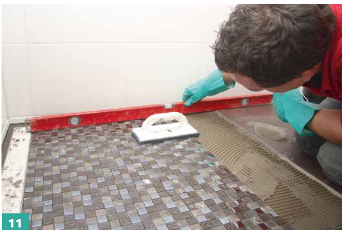
11 Im Bereich bodengleicher Duschen ist darauf zu achten, dass das im Vorfeld hergestellte Gefälle (s. Kapitel 4) erhalten bleibt.
