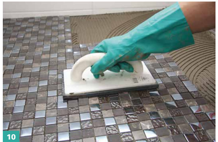
10 Um bei der Mosaikverlegung eine gleichmäßige Oberfläche zu erhalten, das Mosaik gleichmäßig mittels Anklopfbrett andrücken.
