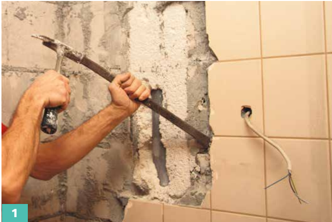
1 Sofern die Verlegung nicht auf dem bestehenden Fliesenbelag erfolgt, den Altbelag von Hand mit Hammer und Meißel ...
