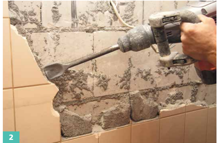
2 ... oder maschinell mittels Bohrhammer und entsprechendem Meißel-Aufsatz abschlagen.
