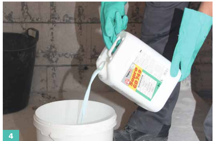
4 Zur Vorbehandlung stark und unterschiedlich saugender Untergründe eignet sich Sopro Grundierung.
