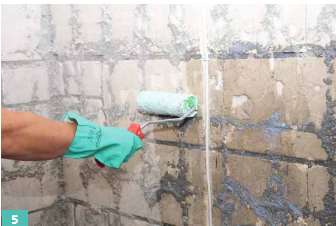
5 Die Grundierung mittels Rolle, Pinsel oder Quast auf den saugfähigen Untergrund (z. B. Mauerwerk) auftragen.
