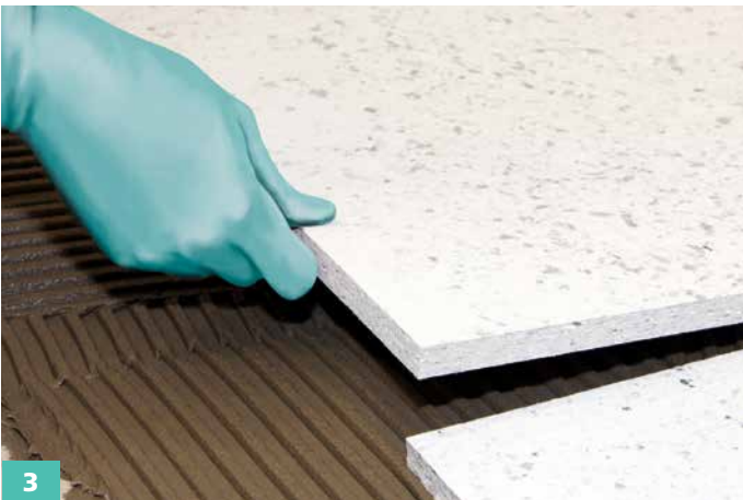
3 Die Verlegung erfolgt Stoß an Stoß.
