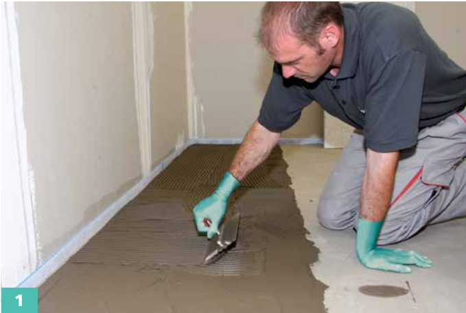
1 Sopro Fliesenkleber mit geeigneter Zahnung auf den vorbereiteten Untergrund auftragen.
