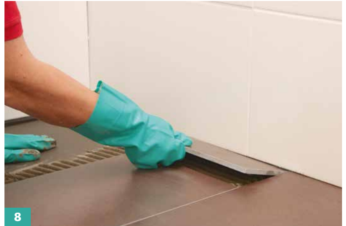
8 Im Eckbereich die Bodenfliese unter die Wandfliese schieben.
