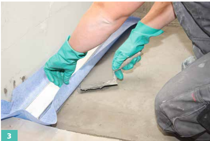
3 Den überstehenden Vliesrand in den Abdichtungsstoff (Sopro TurboDichtSchlämme 2-K) einbetten ...
