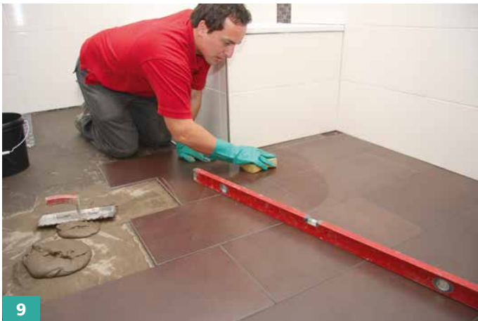
9 Eventuelle Mörtelreste auf dem Belag sind vor der Erhärtung zu entfernen.
