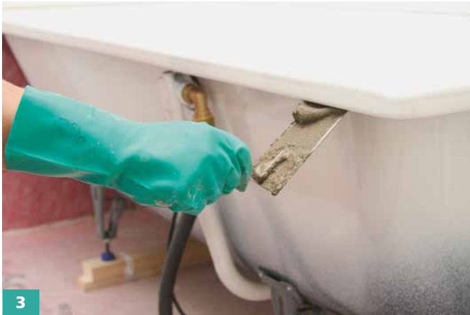
3 Zur Fixierung der Platte, den Kleber sowohl im Anschlussbereich an den Wannenrand ...
