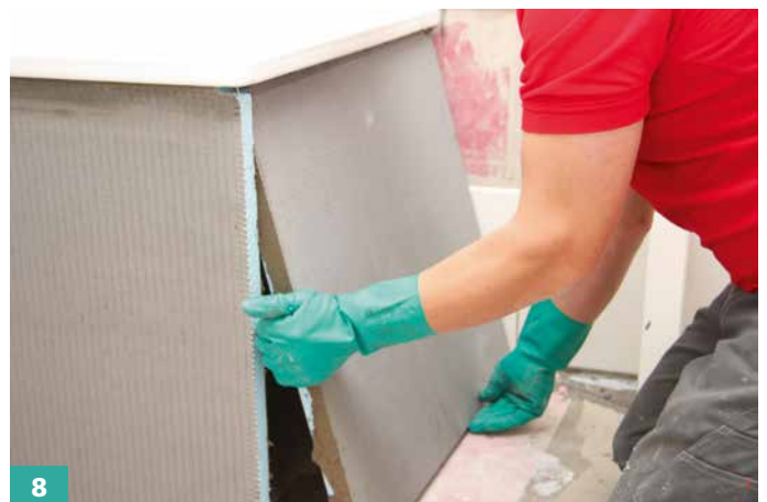
8 Hinweis: Den Kleber auf alle angrenzenden Flächen auftragen. Um eine sichere Verbindung herzustellen, die Platten im Eckbereich auch untereinander verkleben.
