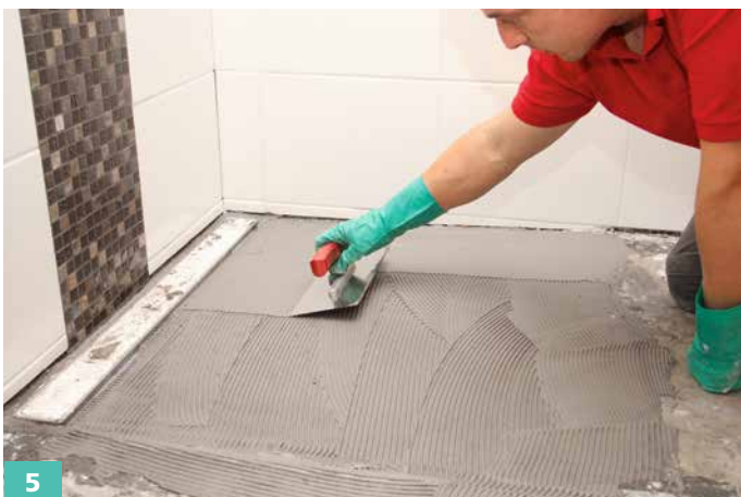
5 Bei der anschließenden Abdichtung der Bodenfläche die Manschette komplett im Zweischichtauftrag überarbeiten.
