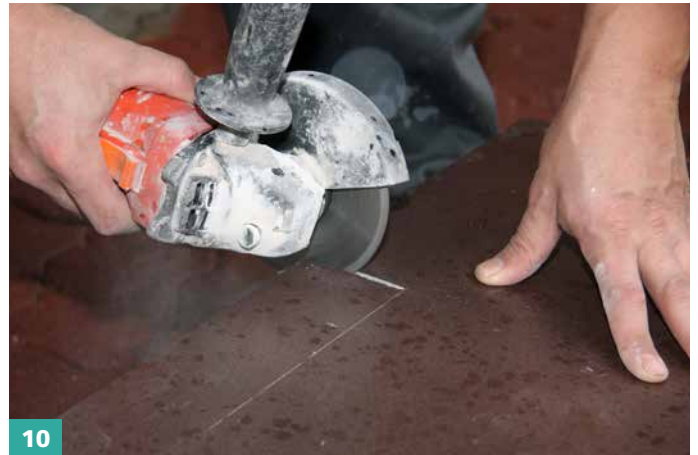
10 Alternativ mittels Winkelschleifer zuschneiden.
