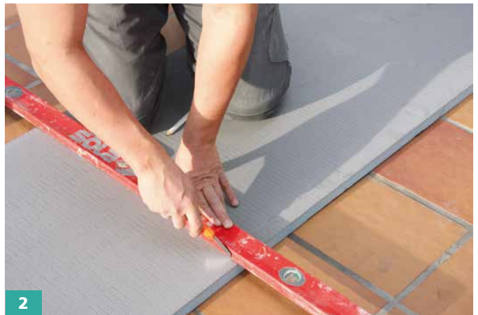
... und die Bauplatte auf die erforderliche Größe zuschneiden.
