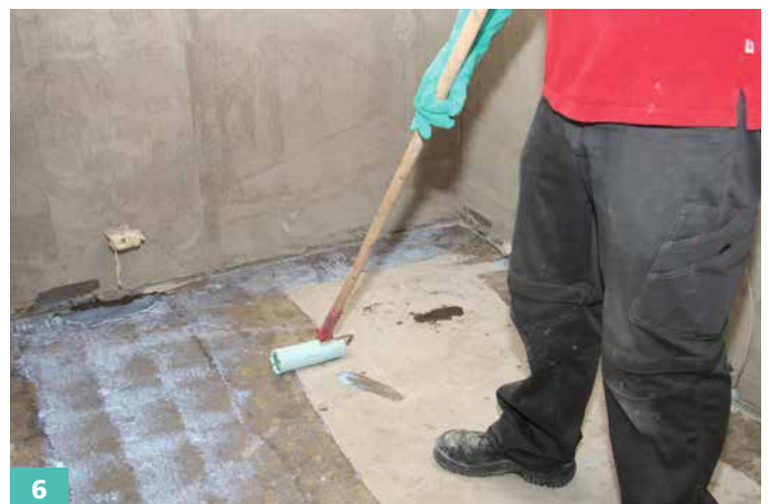
6 Auch saugfähige Bodenflächen (z. B. Zementestriche) werden mit Sopro Grundierung vorbehandelt.
