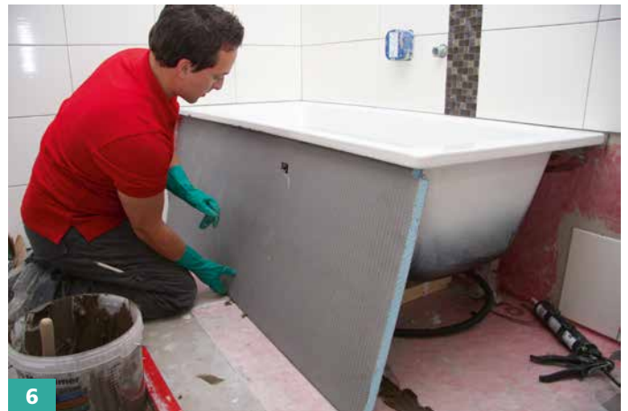
6 Die Platte einsetzen und mittels Wasserwaage ausrichten.
