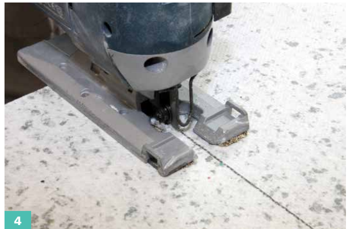
4 Sofern notwendig, die Platte z. B. mittels Stichsäge auf das erforderliche Maß zuschneiden.
