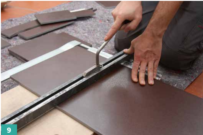
9 Die Bearbeitung von Bodenfliesen erfolgt analog. Die Fliese mit dem Fliesenschneider einritzen und brechen.
