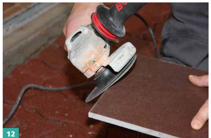
12 Sichtkanten/scharfkantige Kanten mit Diamant-Pad oder Schleifscheibe bearbeiten.
