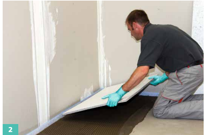
2 Sopro FliesenDämmplatte in das frische Kleberbett einlegen.
