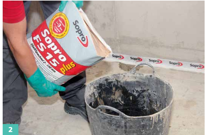
2 Die abgemessene Wassermenge vorgeben, Sopro FS 15® plus zugeben und mittels Rührquirl knollenfrei anmischen.
